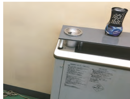
喫煙所には大型の集煙機が設置されていますが、タバコの臭いについてはほとんど効果はありませんでした。
